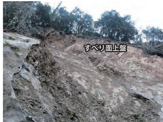
流れ盤亀裂をすべり面とする岩盤崩壊
