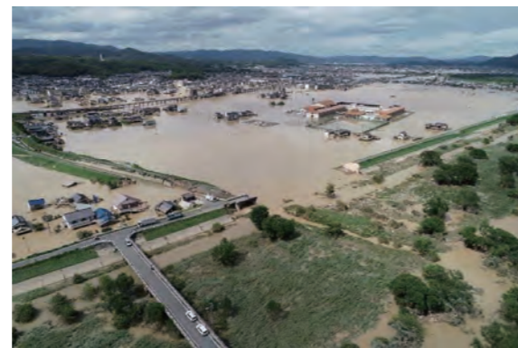
写真-1 西日本豪雨災害
