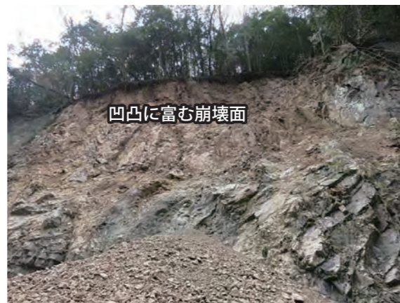
凹凸に富む崩壊面を残す岩盤崩壊
