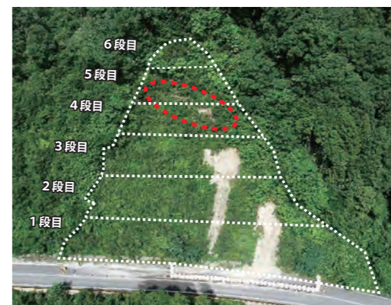
写真2. 法面全体のドローン撮影状況
